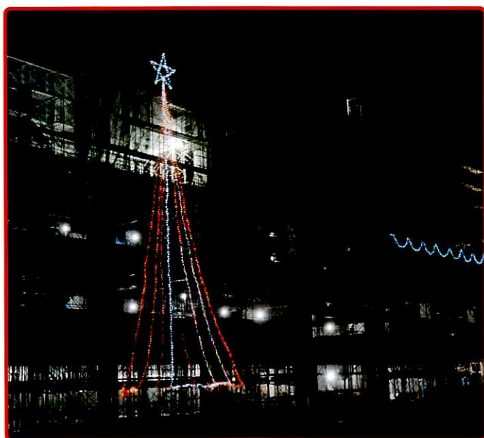
建物西側の外部足場イルミネーション
